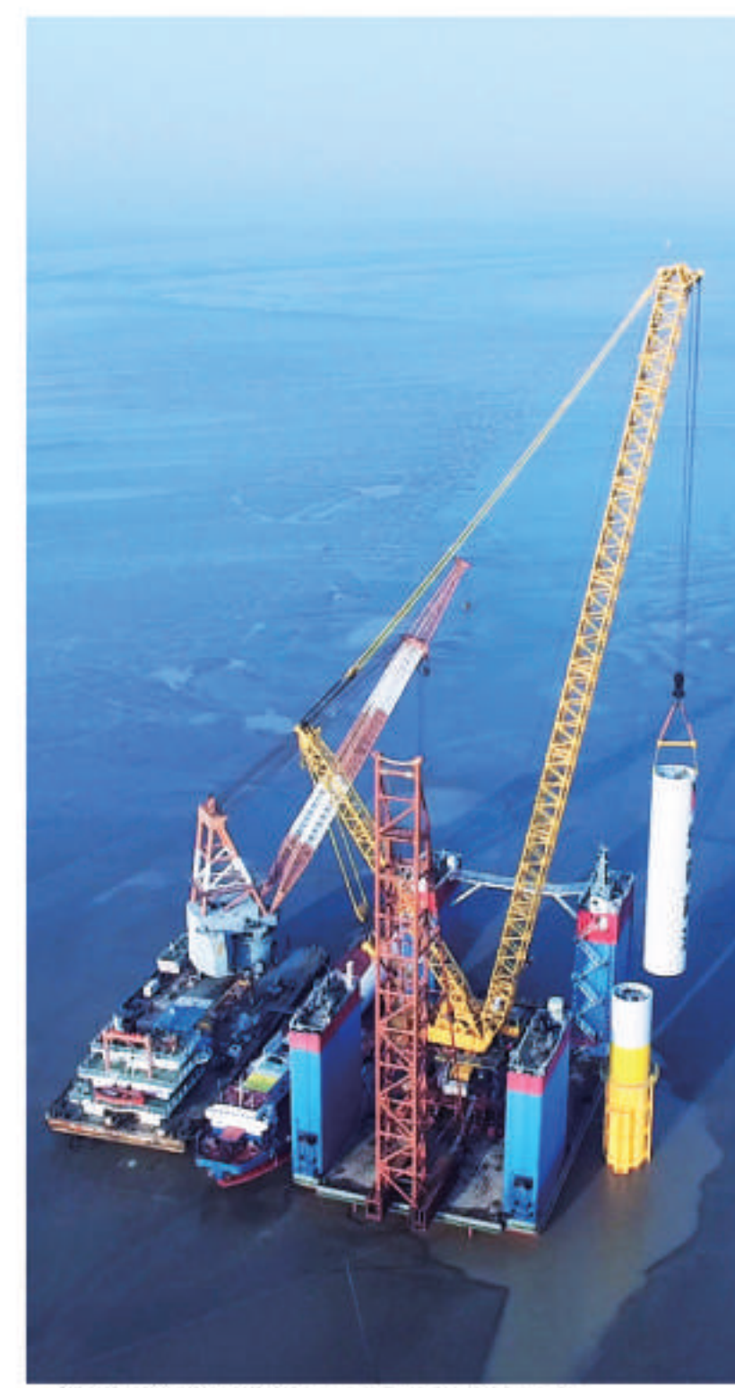
■ XGC28000海上4.0MW风机吊装
