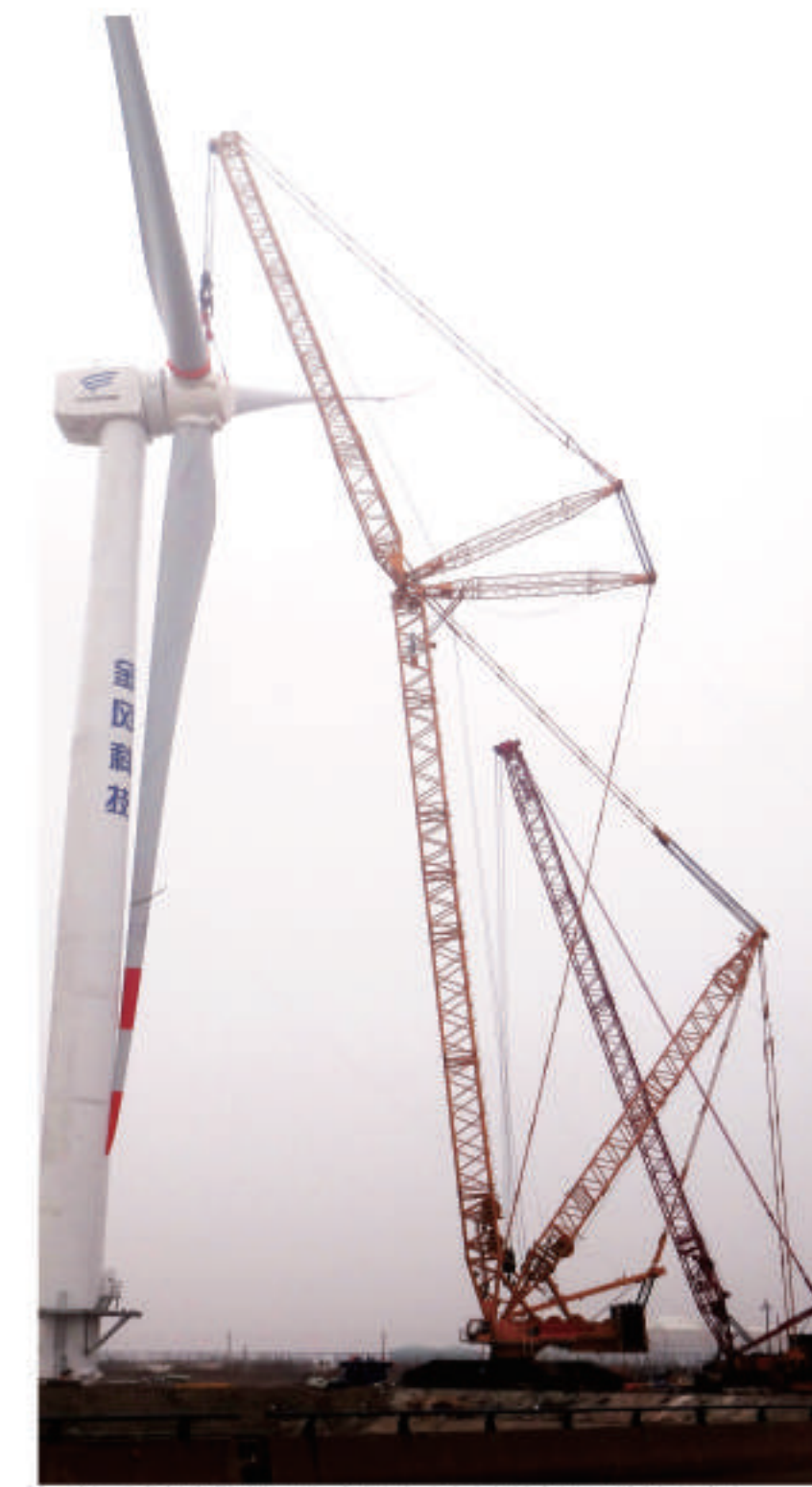
■ XGC16000国内最大功率6MW风机吊装
