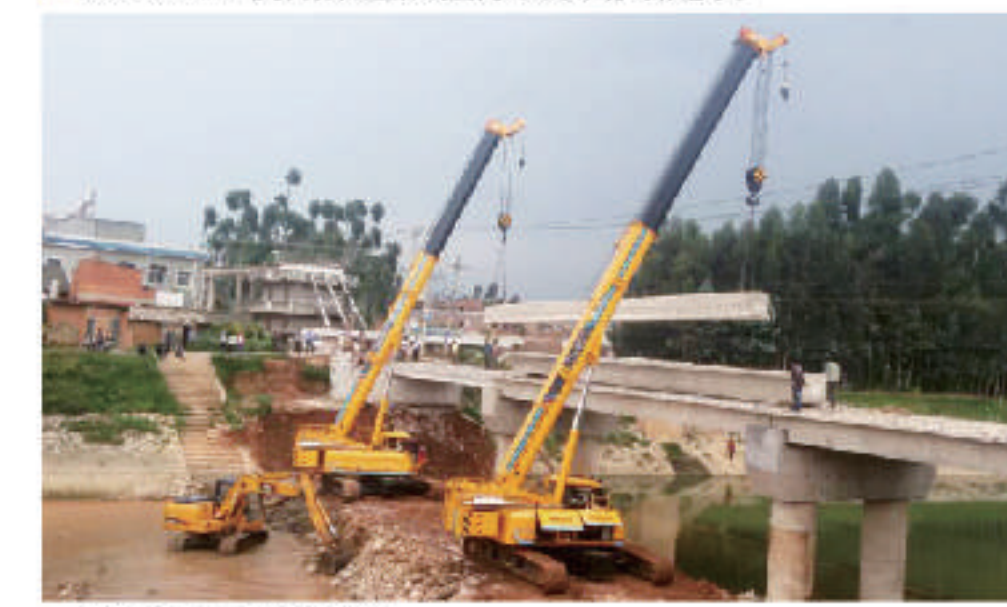
■ XGC55T桥梁建设
