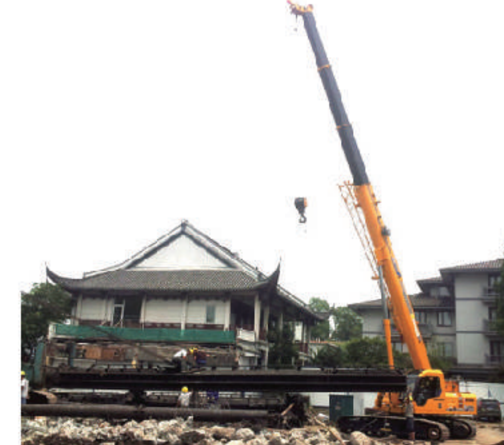
■ XGC25T杭州某重点国际会议场馆建设
