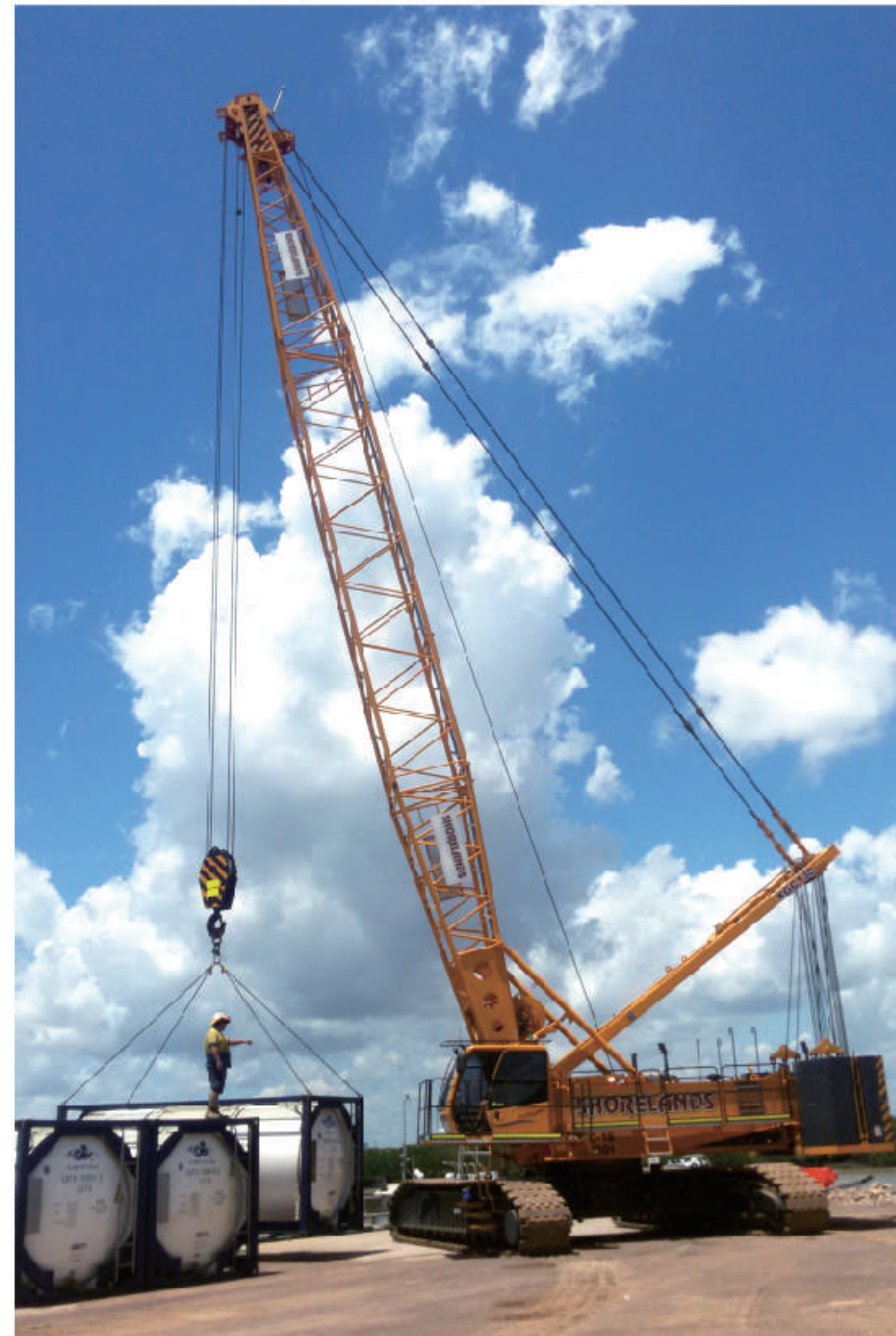
■ XGC130澳大利亚施工
