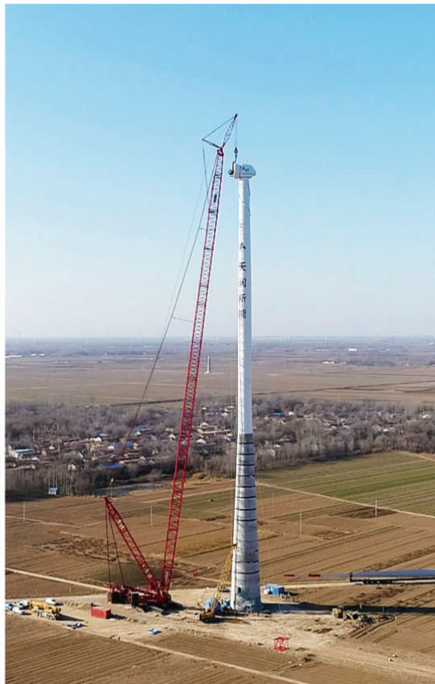
■ XGC650成功吊装140米高风机
