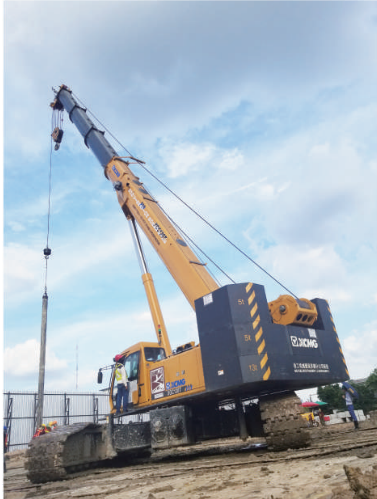
■ XGC120T泰国曼谷基础建设项目施工
